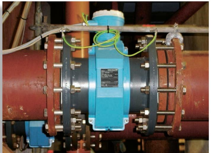
Durchflussmessung einer abrasiven Salzsuspension mit Promag 55S.
