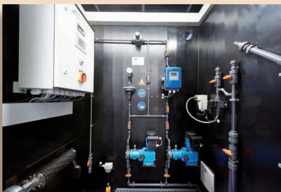
Das Innenleben der Dosierstation im chemikalienbeständigen Schutzschrank von Alltech Dosieranlagen.
