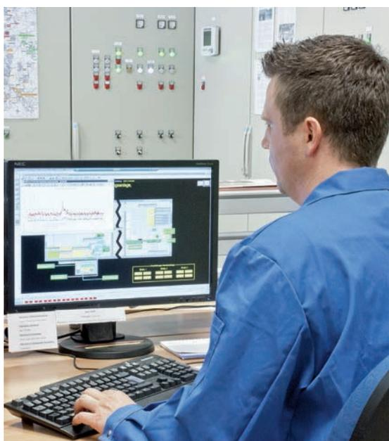
Während des Betriebs der Pumpe wird die anlagenspezifische Referenzmessung permanent mit den laufenden Betriebsdaten abgeglichen. Wird bei KP und KL der Grenzwert von 50% unterschritten, gibt das System eine Warnung aus. Ab nur noch 20% wird die Abschaltung der Pumpe empfohlen. Quelle: Homa Pumpenfabrik GmbH
