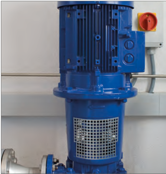
Tauchmotorpumpe in vertikaler Aufstellung
