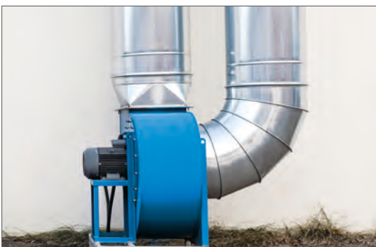
Radialventilator mit Direktantrieb
