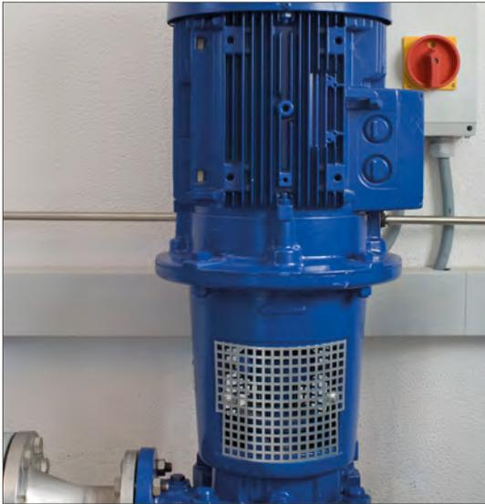
Tauchmotorpumpe in vertikaler Aufstellung
