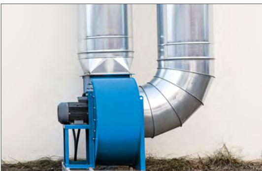
Radialventilator mit Direktantrieb
