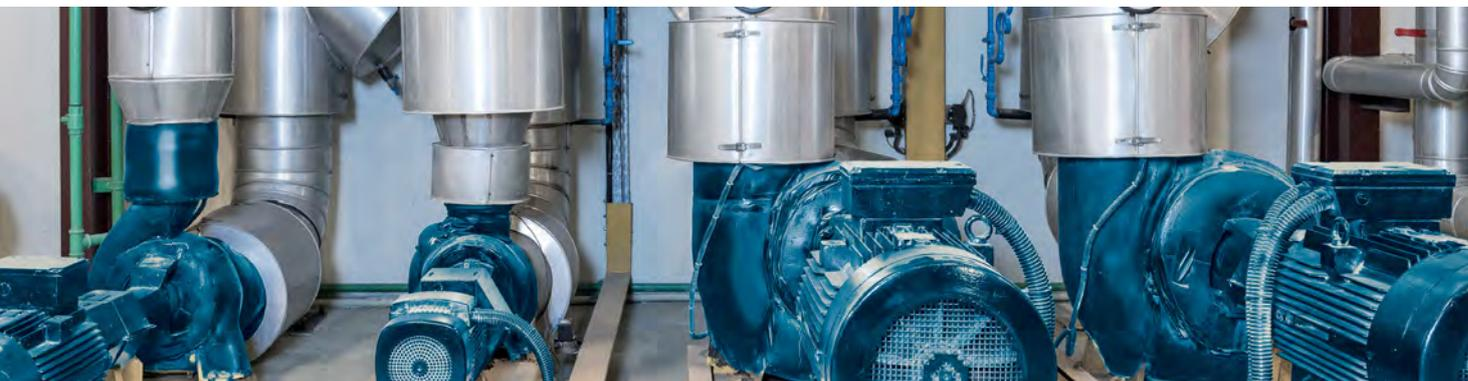
Schwingungs- und Druckmessung sind typische Instrumente zur Maschinenüberwachung von Kreiselpumpen und Radialventilatoren. Durch die Überwachung dieser Parameter lässt sich eine erhöhte Maschinenverfügbarkeit erreichen und Stillstandszeiten vermeiden. Auf diese Weise erhöht sich die Anlageneffizienz und die Betriebssicherheit, was zu einer Kostensenkung bei der Instandhaltung führt.
