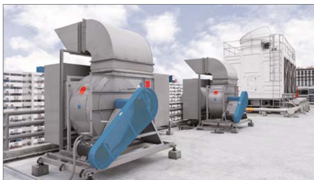
Radialventilator mit Riemenantrieb
